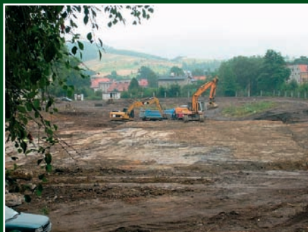
Budowa Aqua Zdroju rozpoczęta
